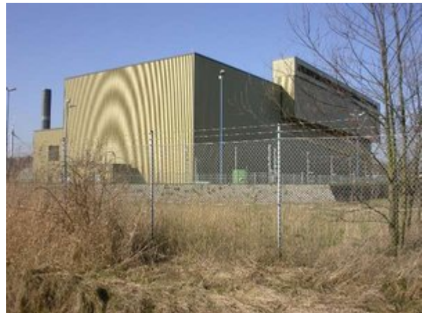
Abbildung 1: Foto: contratom Zwischenlagerhalle Brunsbüttel
