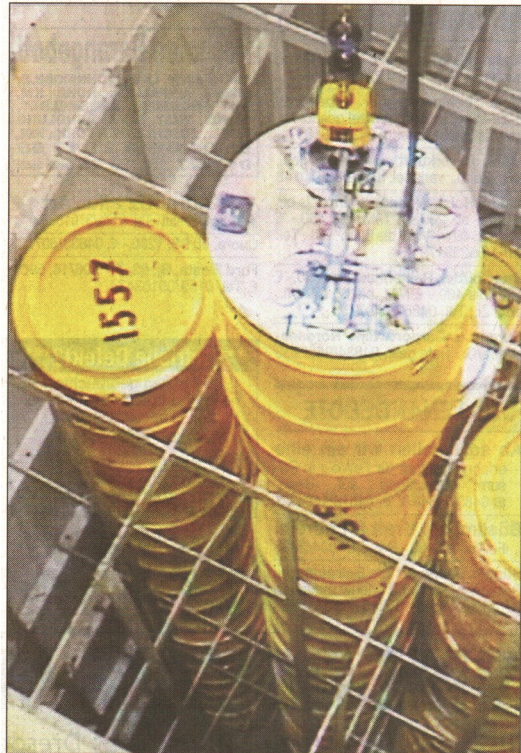
Die Atommüllfässer in den Kavernen sind zum Teil erheblich verrostet. Foto: Vattenfall
