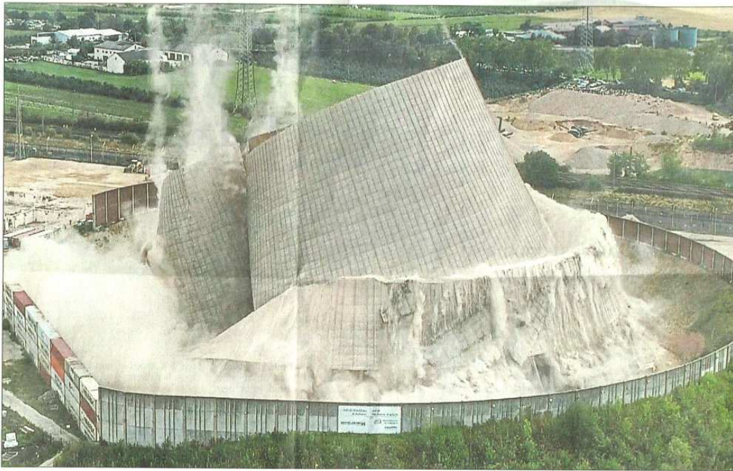
Beim Rückbau eines Atomkraftwerkes fällt am Ende eine Menge Bauschutt an, wie hier eine Aufnahme vom Sommer zeigt, wo der Kühlturm des Kernkraftwerks Mülheim-Kärlich (Rheinland-Pfalz) kontrolliert zusammenstürzt, nachdem Bagger nacheinander Stützen entfernt hatten. Foto: Frey
